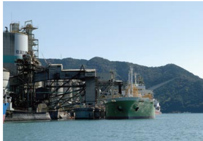
セメントタンカーへの積み込み
