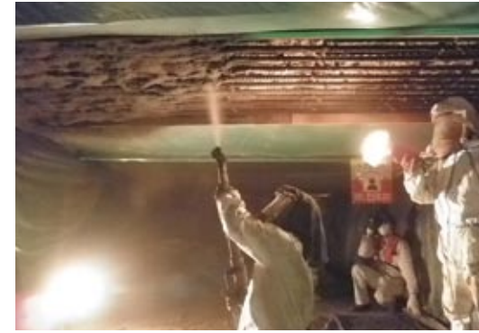
橋梁補修工事
