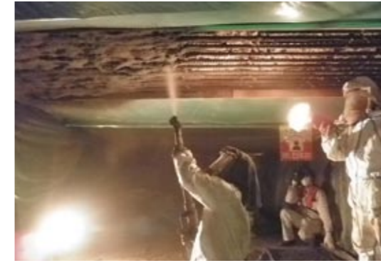
橋梁補修工事
