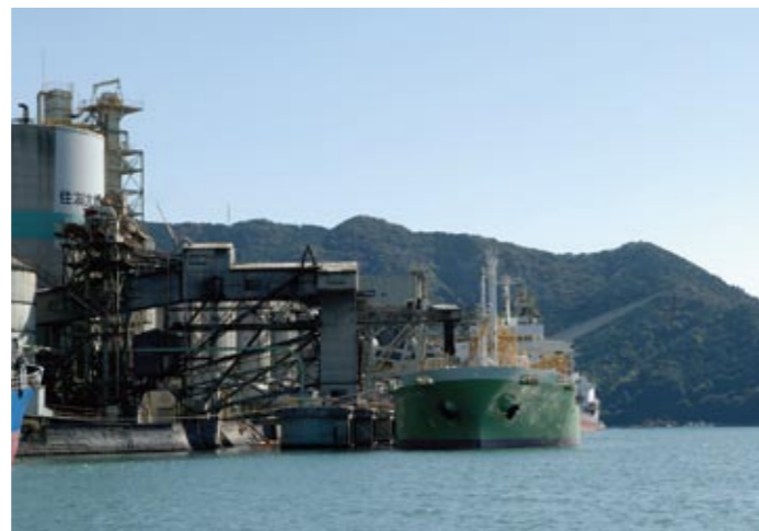
セメントタンカーへの積み込み
