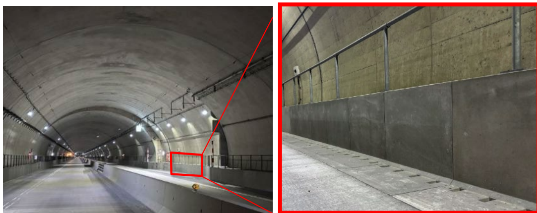
写真3. トンネル坑内での実証 荒島第二トンネル工事（縦壁付矩形水路）
