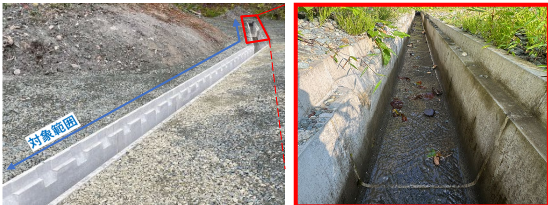
写真2. 寒冷地での実証 成瀬ダム原石山採取工事（落蓋式U形側溝）※左は施工当初の写真
