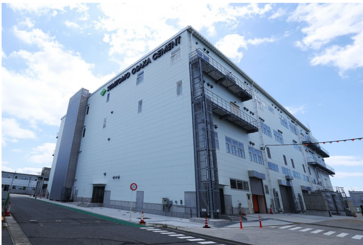
写真2. 新製造棟外観
