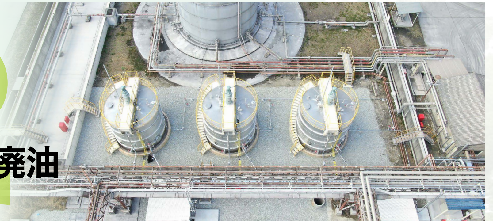
増設した廃油タンク（赤穂工場）
