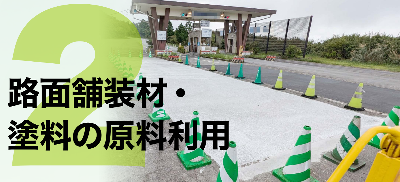
「次世代低炭素型半たわみ舗装」を施工した路面
