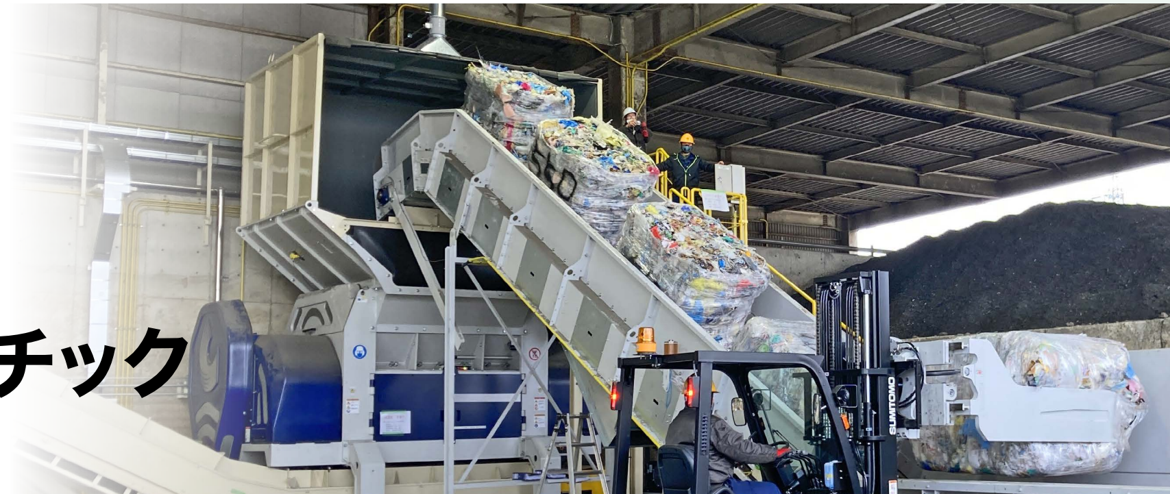
新設した廃プラスチック破砕機（赤穂工場）
