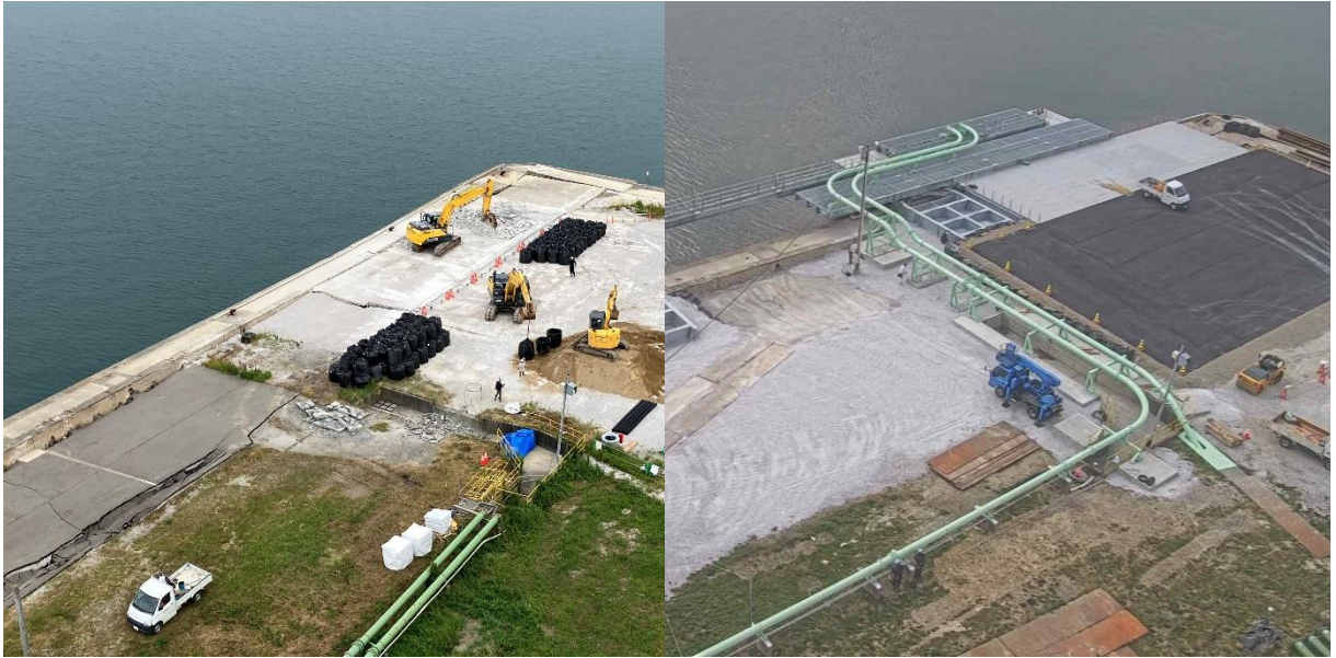
本格復旧工事前(写真左)と、復旧が進みドルフィン新設中の七尾港S S(写真右)
