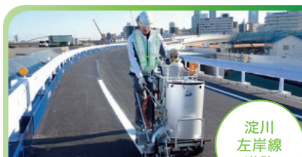
淀川左岸線 道路白線
