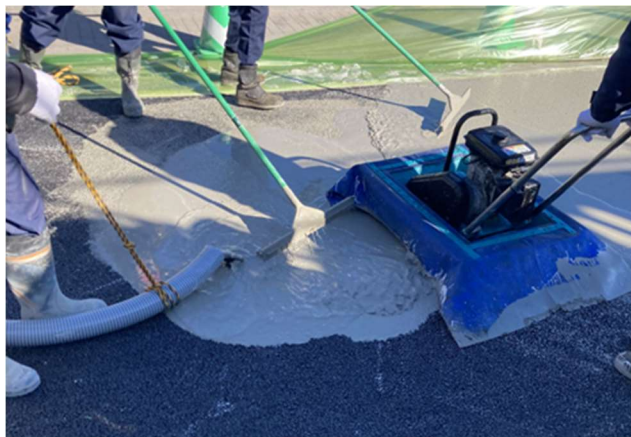
図3 試験施工の状況(セメントミルクの注入)
