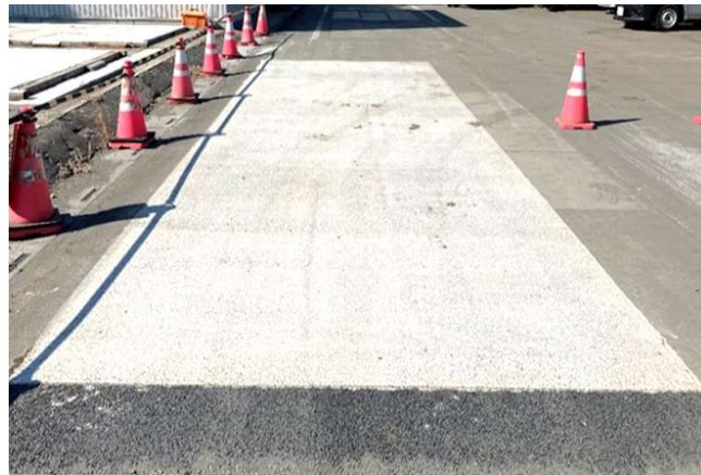
図4 供用後の状況
