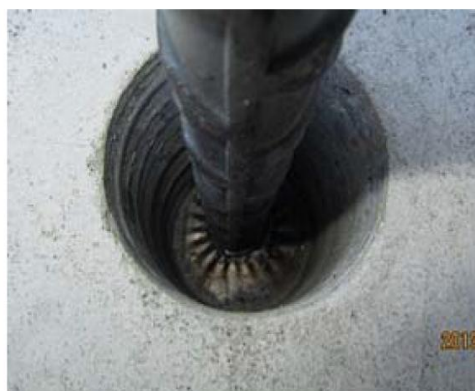
b) 孔内溶接完了後
