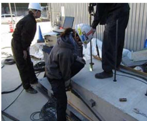
a) スタッド溶接状況
