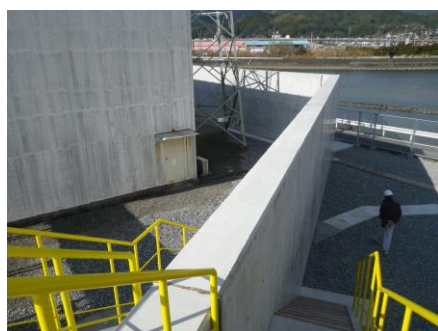
高知工場 第一変電所防潮堤工事
