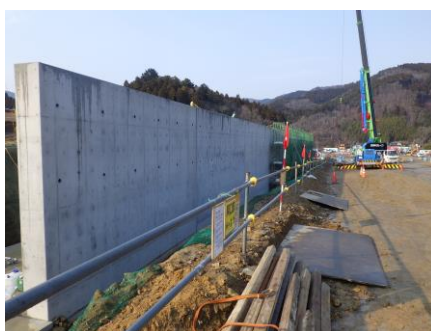
女川浜駅周辺工区整備 L型擁壁工事
