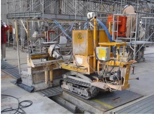
写真-3 WJ 工法によるはつり状況
