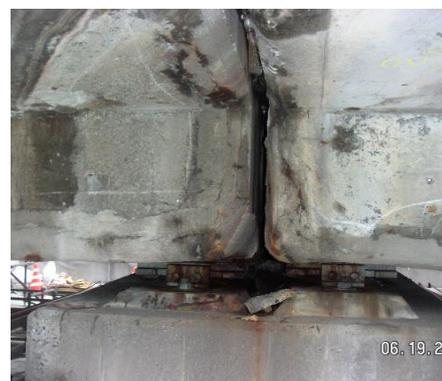
写真-1 主桁端部の劣化状況
