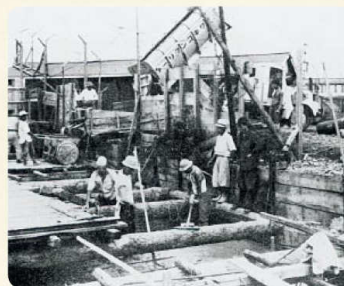
当時の地下鉄工事での生コン打設作業
