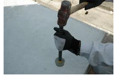
写真4-3. アンカー挿入
