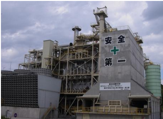
栃木工場バイオマス発電設備
