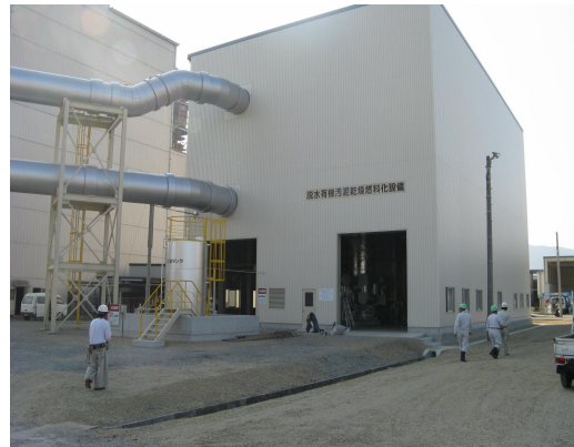
(乾燥・燃料化設備全景)
