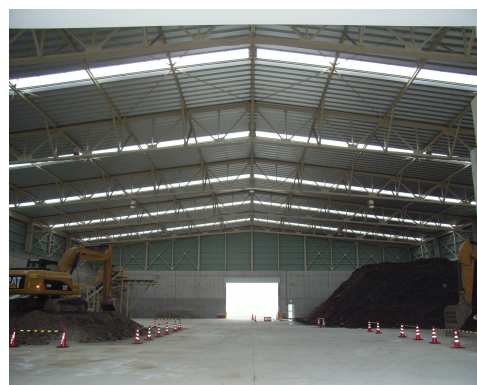
（建設発生土ヤード内部）
