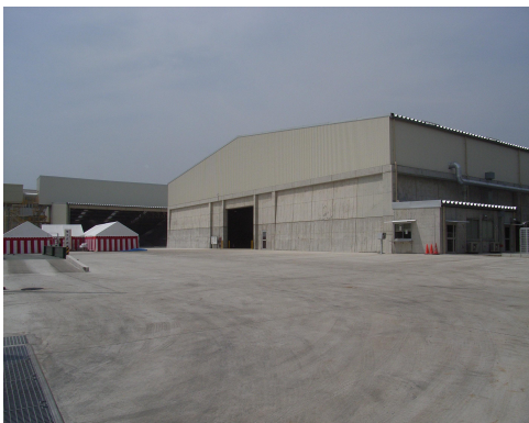
（市川リサイクルセンター全景）
