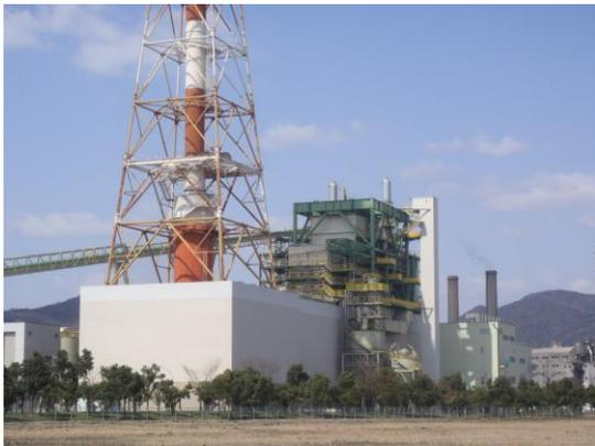
発電出力 102,500kW を誇る当社グループ最大の火力発電設備。主な燃料は石炭を使用しており、赤穂工場のセメント製造用電力等の全量を賅うとともに、余剰電力は外部に供給しており、地域社会における電力の安定化の一端も担っている。
