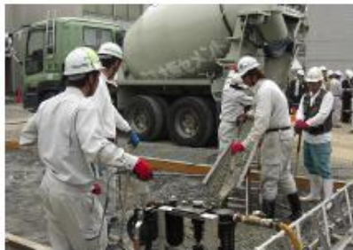
アジテータ車からのコンクリート荷降ろし 打設量は7.2㎡
