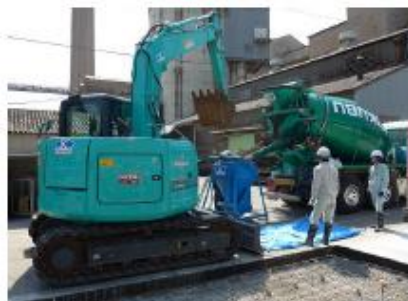
アジテータ車よりホッパー(5002)への 荷降ろし
