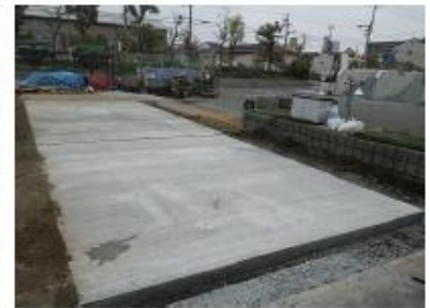
施工1日後の状況 24時間で目標を上回る強度(4.84N/mm 2 )を確認
