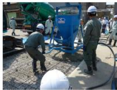
ホッパーからの打設
