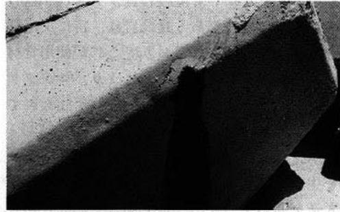
写真5 黄鉄鉱によるポップアウトと、褐色の錆汁の流下 直径9cm
