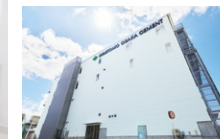
静電チャック(ESC)新製造棟 (千葉県市川市)
