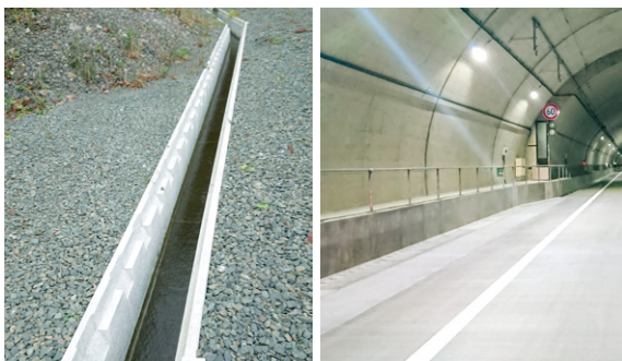
人工石灰石を用いたCO 2 固定コンクリートのプレキャスト製品の実証施工箇所(左:成瀬ダム原石山採取工事(落蓋式U形側溝) 右:荒島第二トンネル工事(縦壁付矩形水路))
