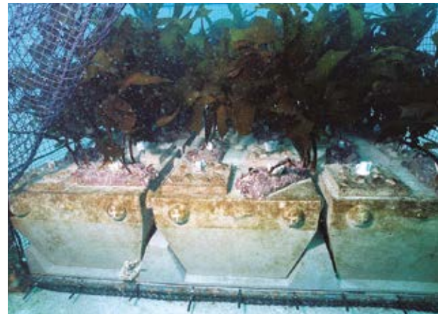
多機能型藻場増殖礁「K-hat リーフβ型」の中で繁茂する海藻(沈設後約2年)
