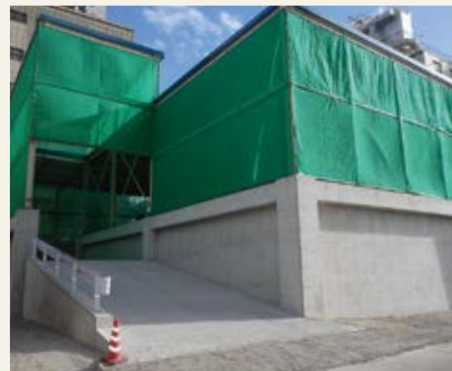
赤穂工場 置場全体外観(熱エネルギー系廃棄物の置場)
