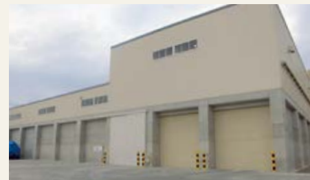
八戸港 一般焼却灰選別施設
