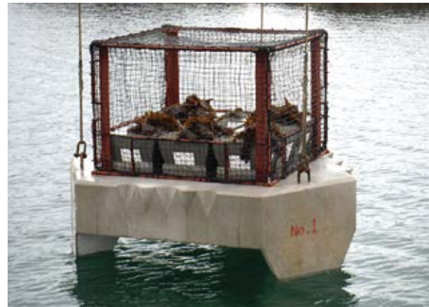
沈設中の多機能型藻場増殖礁「K-hat リーフβ型(エビクルハウス付)」
