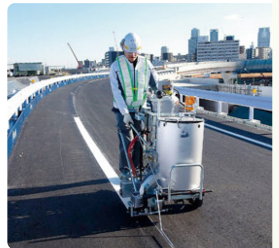
CO 2 再資源化人工石灰石を利用した路面標示用塗料を施工する様子
