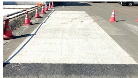
「次世代低炭素型半たわみ性舗装」供用後
