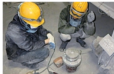
簡易バキュームのテストの様子
