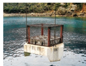
藻場礁の沈設作業
