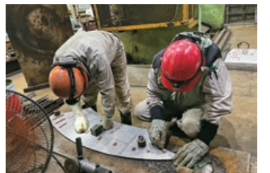
現場での作業の様子
