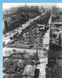
早強セメントを利用した 大阪市地下鉄工事
