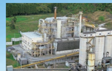
バイオマス発電設備
