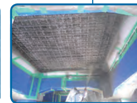
栈橋の断面修復
