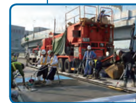
橋梁の床版補強
