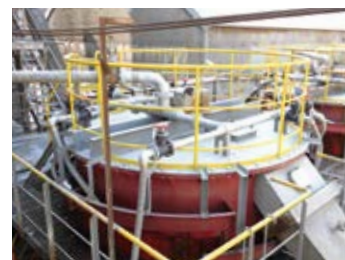
No.3セメントクーラー 上部手摺り改修
