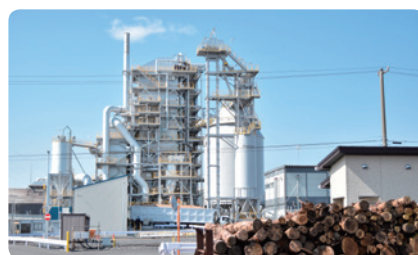
八戸バイオマス発電所(青森県 八戸市)
