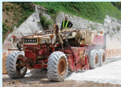
吸着層工法によるマジカルフィックス®敷設の様子
