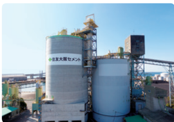
小名浜サービスステーション (福島県 いわき市)
