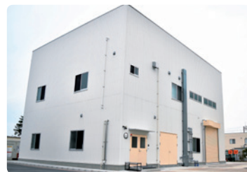
新設備棟(千葉県 市川事業所)
