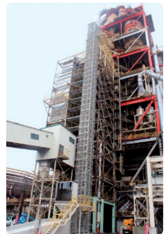
赤穂工場ASR投入設備
