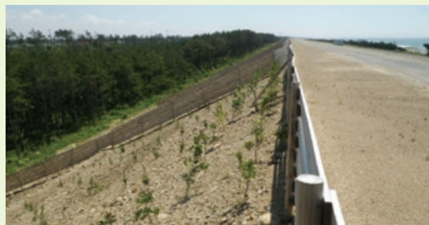
盛土箇所の海岸防災林の植樹の様子
