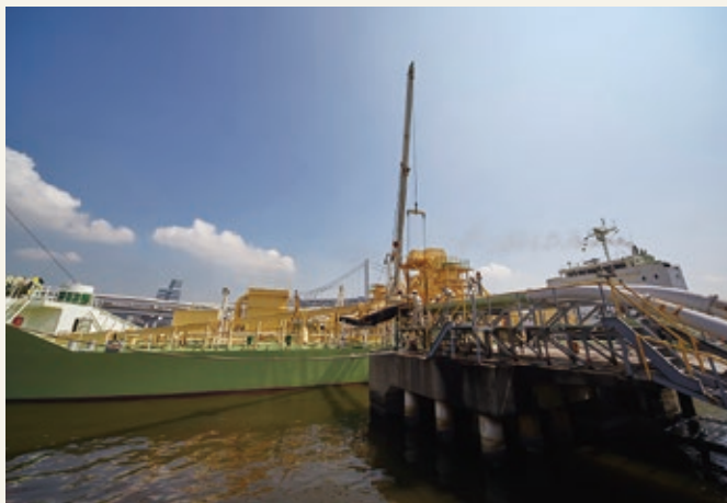
セメントタンカーからサービスステーション(芝浦)への荷揚げ
