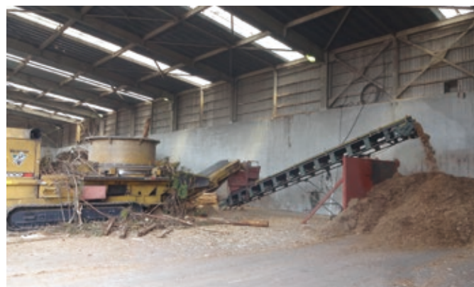
高知工場木くず破砕処理設備
