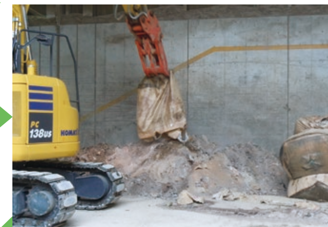
罹災米フレコン解体
