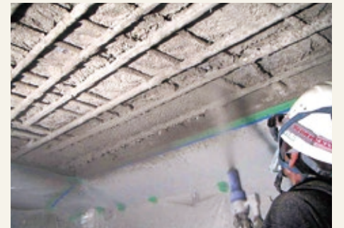
橋梁補修工事
