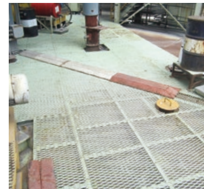
各サイロ上甲板踏み抜き防止対策
