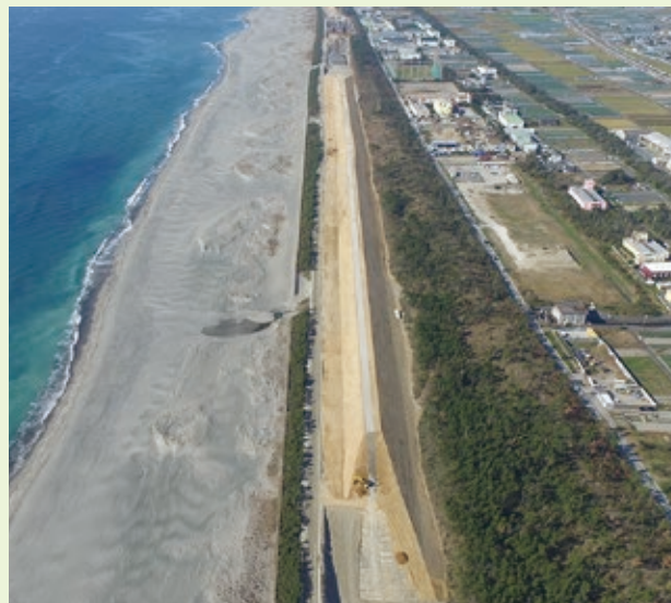
浜松市沿岸域防潮堤～篠原2工区の築堤～
