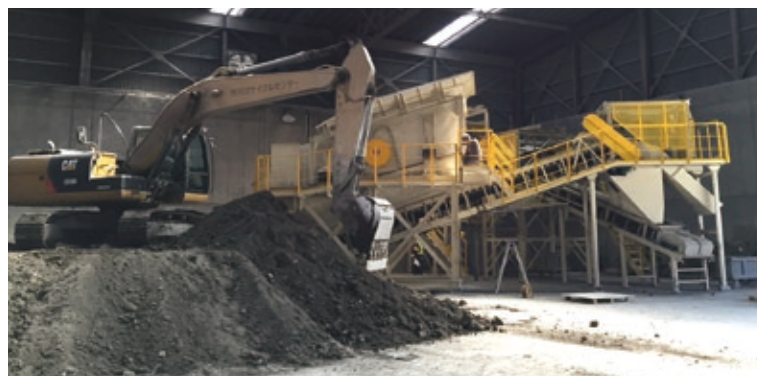
市川リサイクルセンター
