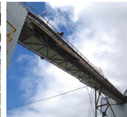
石灰石落石防止設備の更新
