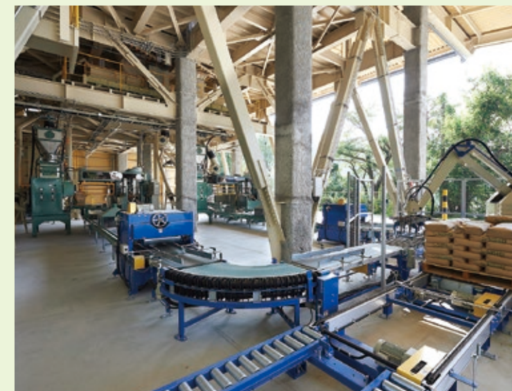
泉工業(株) 建材製品製造プラント
