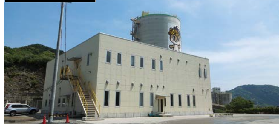
中央操作室の高台への移設
