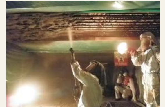
橋梁補修工事
