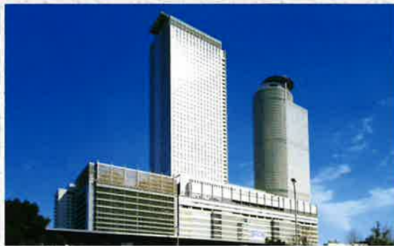
JRセントラルタワーズ【施工:JRセントラルタワーズ新設工事共同企業体/愛知県】
