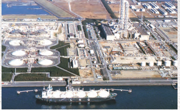
富津火力発電所[東京電力(株)/千葉県]
