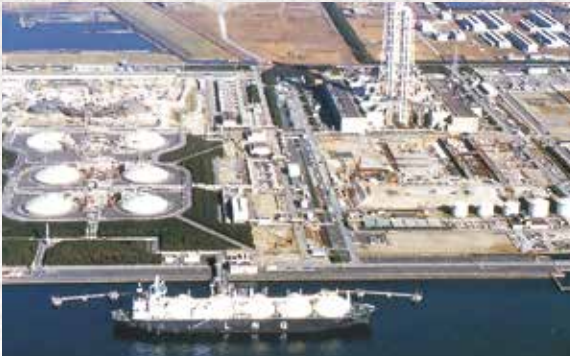
富津火力発電所[東京電力(株)/千葉県]
