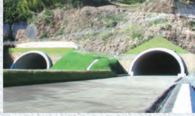
第二東名清水第四トンネル【静岡県】
