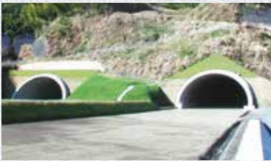
第二東名清水第四トンネル【静岡県】
