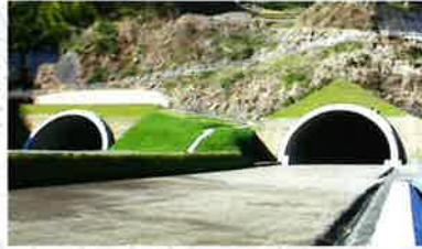
第二東名清水第四トンネル【静岡県】
