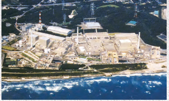
浜岡原子力発電所 [中部電力(株)/静岡県] 写真提供/中部電力(株)
