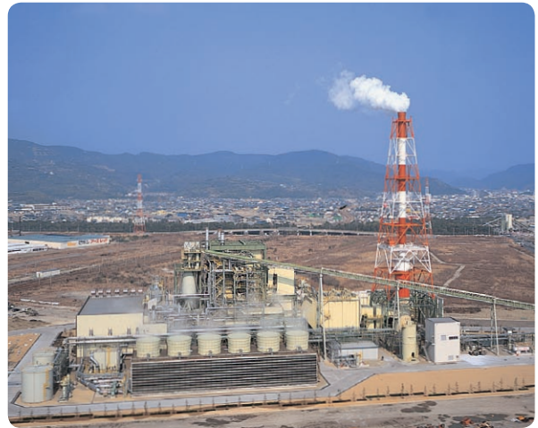
赤穂工場自家発電設備
